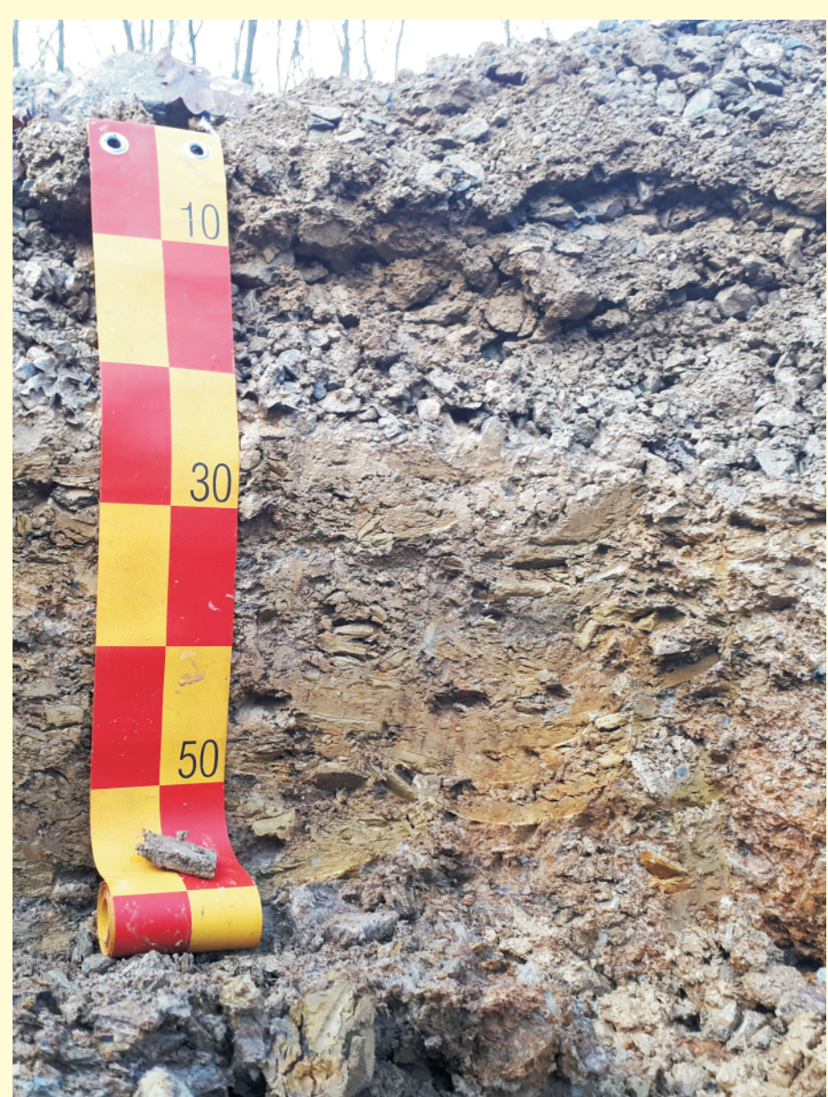
Abb. 1: Bodenprofil (Versuchsfläche Sb) mit ca. 35 cm mächtiger Schotterauflage ohne Unterbodenstabilisierung.
